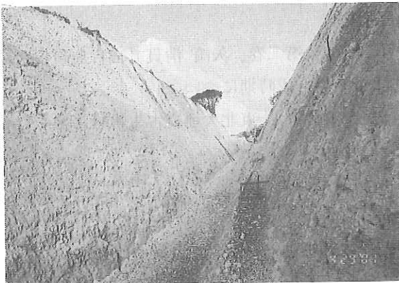
(写真5) 平良市大浦地区 洲本原(スプ嶺) 宮古島石灰岩 上位層(平良石灰岩) 石灰藻球、イタヤガイ等を含む、 排水路整備工事現場(2001, 3)
